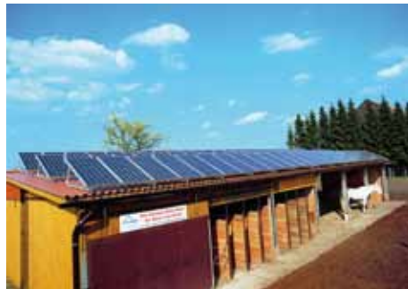
Abb. 8: PV-Anlage auf landwirtschaftlich genutztem Gebäude.
